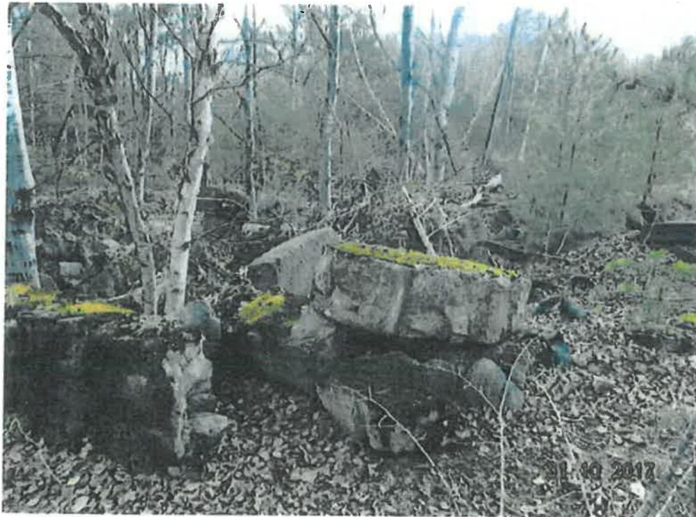
Mos-2017-10-31-006 – Débris de béton (D) (vue vers le Nord-Ouest)
