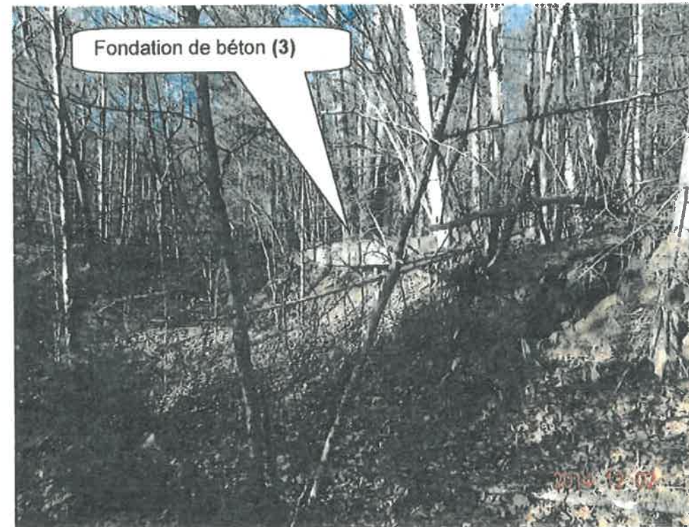
Mos-2014-12-02-004 - Vue de la Fondation de béton (3) (vue vers le Nord-Ouest)
