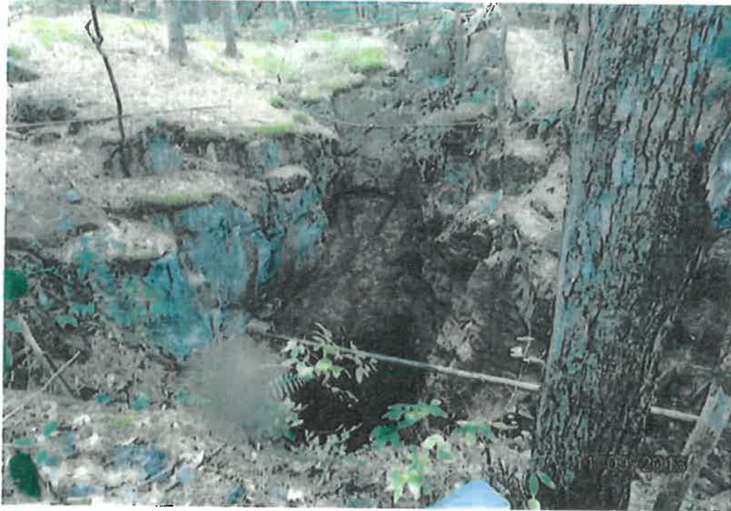
Mos-2018-09-11-004 – Fosse 4 à sécuriser par remblayage (vue vers l'Est)
