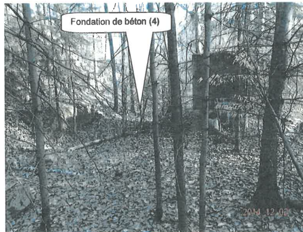
Mos-2014-12-02-008 - Vue de la Fondation de béton (4) (vue vers le Nord-Est)
