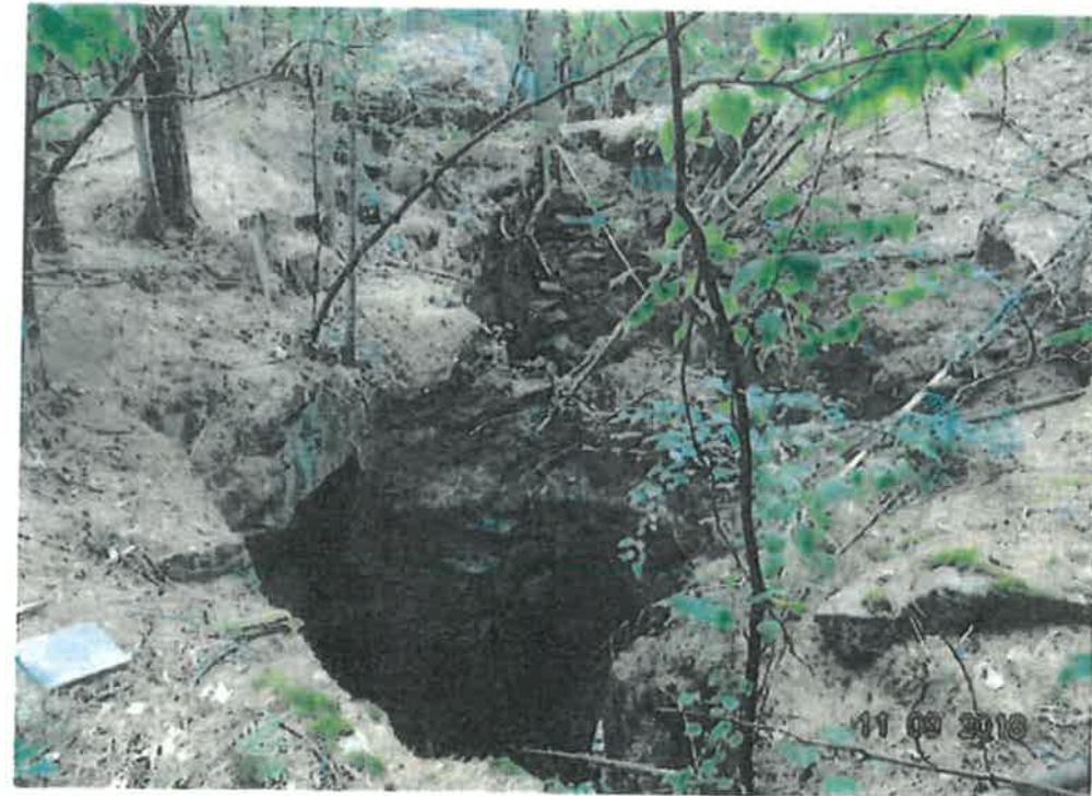
Mos-2018-09-11-005 – Fosse 5 à sécuriser par remblayage (vue vers le Sud-Ouest)
