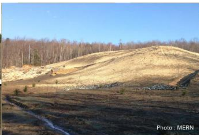
Cellule de stériles miniers une fois les travaux complétés.
