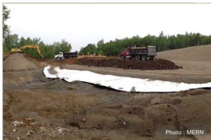
Début de la mise en place des stériles miniers dans la cellule.
