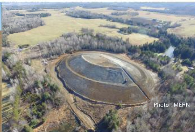
Vue aérienne du parc B après les travaux d'excavation et de profilage.
