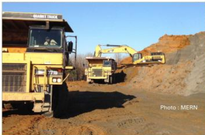
Excavation de résidus miniers au parc B.
