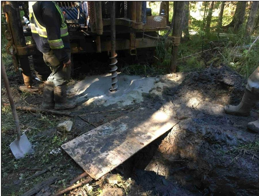
**Photographie 2** : Vue de la réalisation du forage 18PO1
