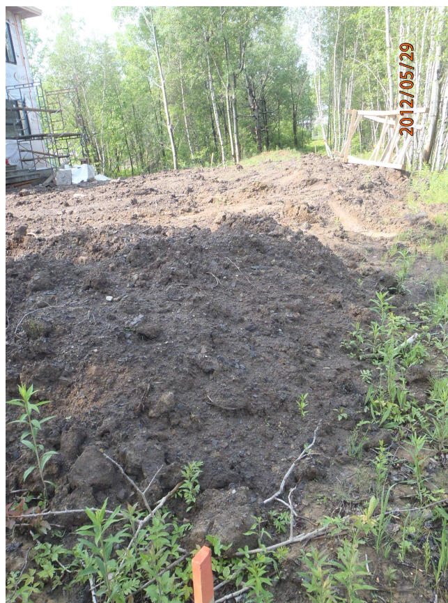
Photo 6. Zone de remblai et arbres coupés dans la zone de conservation no 1
