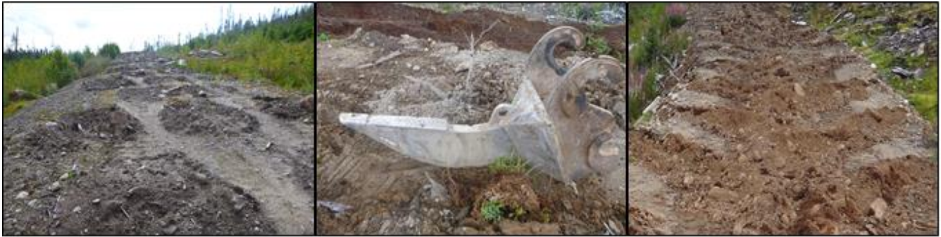
Figure 7. Préparation de chemin en poquets (gauche), attache griffe (centre), et motif « Y » utilisé avec la griffe (droite).
