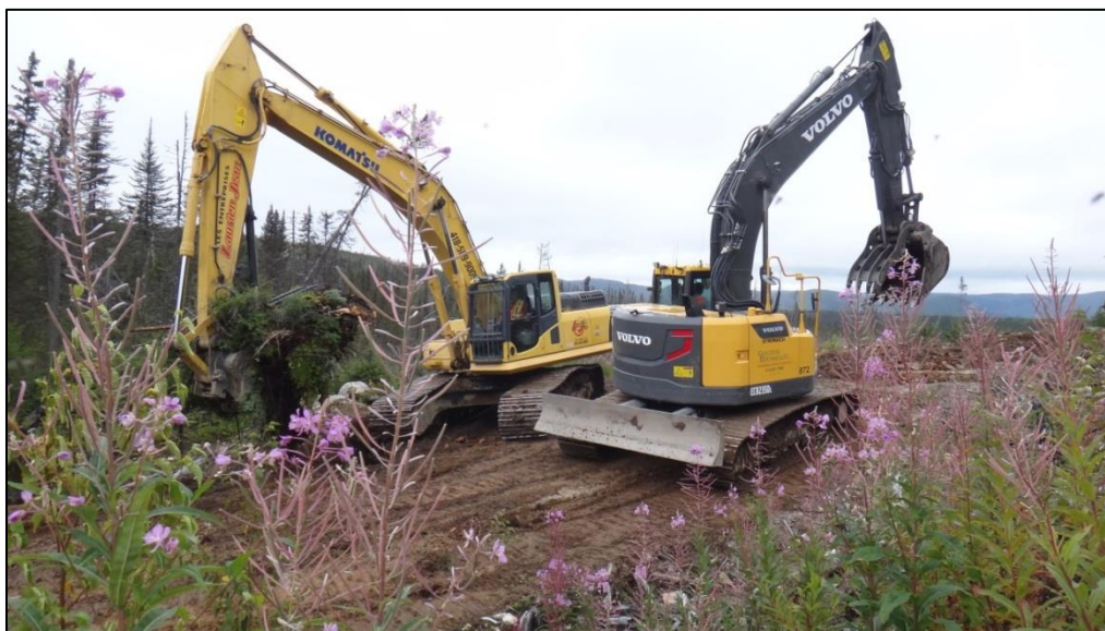
Figure 11. Excavatrice primaire (Komatsu) chargée de mousse en attente d'une excavatrice secondaire (Volvo) pour se déplacer.
