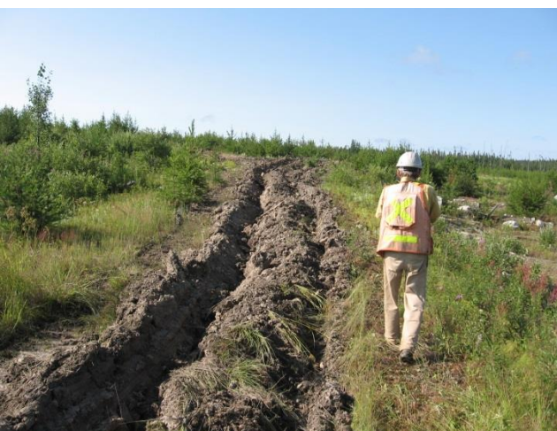
Figure 2 : Chemin d'opérations désactivé par le bouteur
