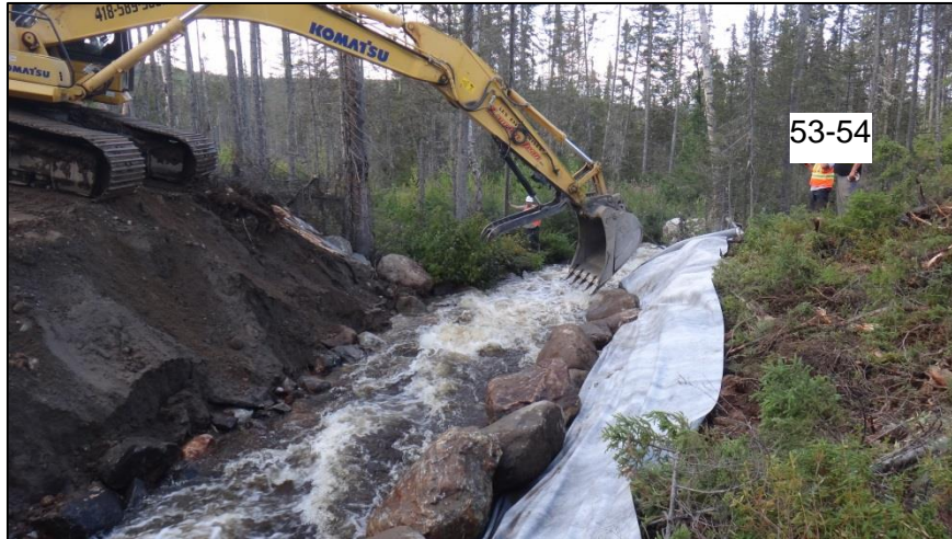
Figure 4. De grosses roches placées pour retenir le géotextile et pour créer la fondation de l'empilement rocheux.
