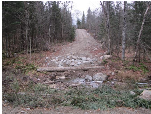
Figure 7 : Site stabilisé où un pont en acier temporaire a été enlevé.
