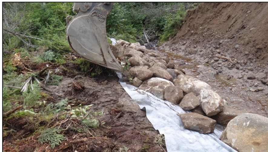
Figure 5. Les roches de remplissage plus petites sont plus susceptibles de tomber dans des trous plutôt que de rouler dans des cours d'eau.
