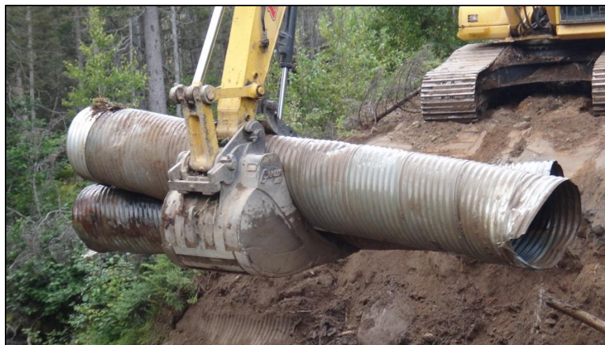
Figure 3. Enlever le tuyau avec le « doigt » de l'excavatrice.
