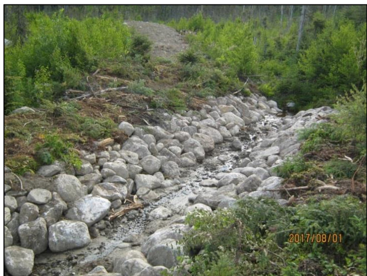
Figure 10. L'épaisseur de la couche de roche est supérieure
