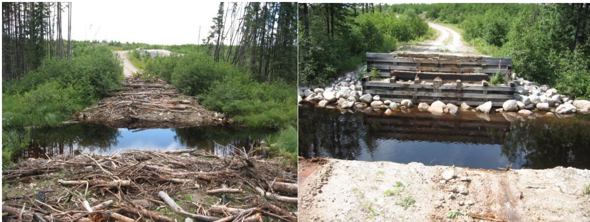
Figure A1 : Désactivation d'un ponceau
