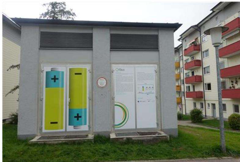
*Figure 3-2 Système de stockage ELSA – projet pilote dans un district allemand (ELSA, 2017)*
