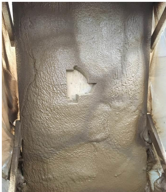
Figure 5. Mur couvert de la mousse de polyuréthane biosourcée
